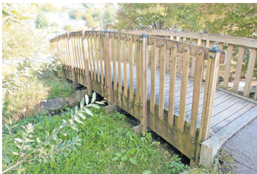
Brücken braucht es überall – auch in Adligenswil.
