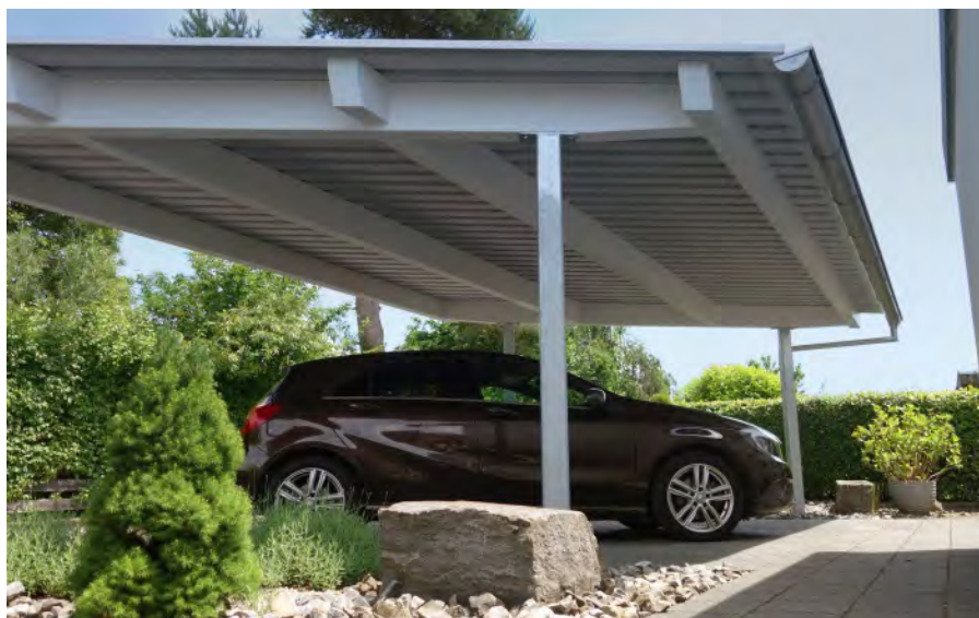
Carport mit Trapezblechdach
