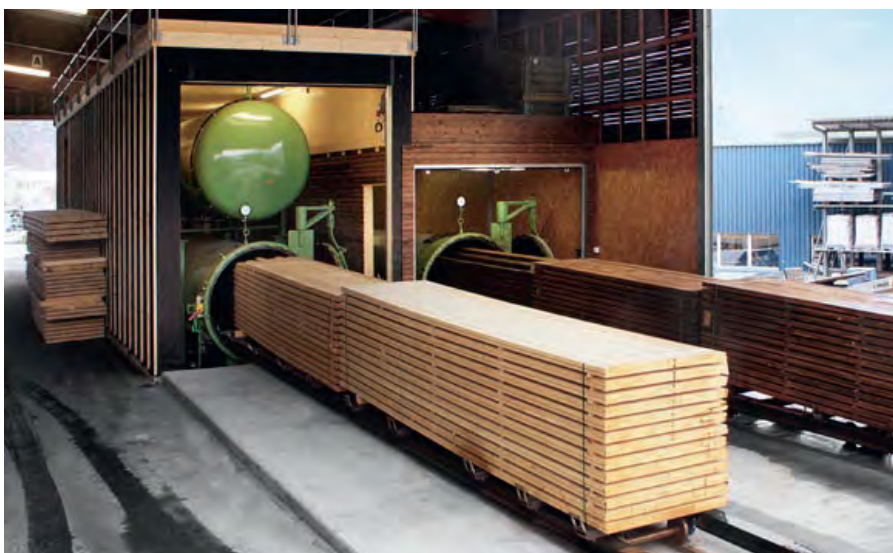
Die hochmoderne und umweltschonende Imprägnieranlage in Willisau.
