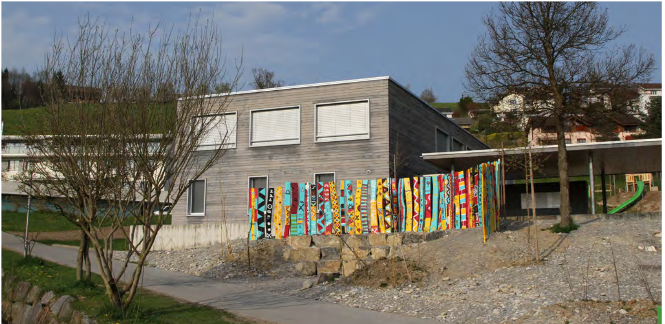
Eine Situation, die viele Gemeinden kennen: Für den steigenden Schulraumbedarf werden zunächst Provisorien erstellt, wie hier die Schulanlage Kehlhof in Adligenswil LU. Aus den Provisorien werden dann Dauerlösungen, weil sich die komplexe Planung von neuem Schulraum hinzieht.
