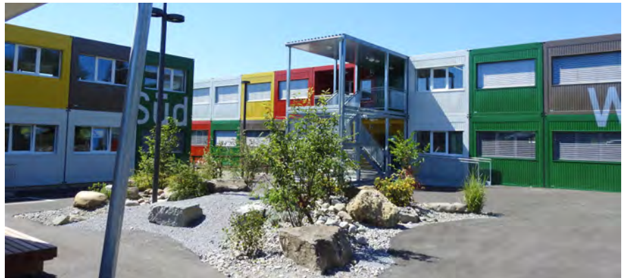
Die ideale Lösung, um eine vorübergehende Platzknappheit an Schulen abzudecken – hier in Pfäffikon ZH.
