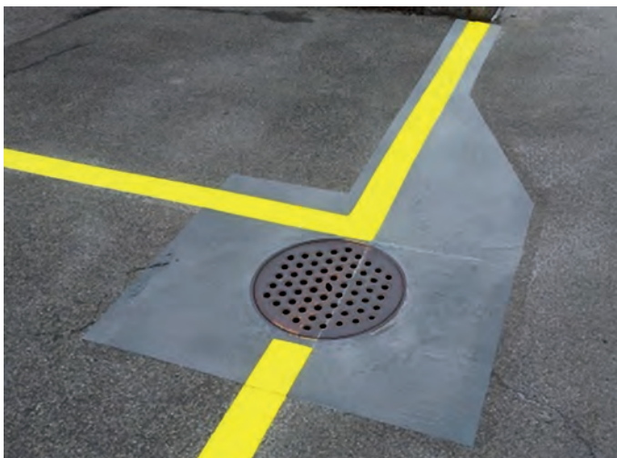
Mit dem Spezialprodukt BascoRep werden kleinere Schlaglöcher oder Belagsrisse in sehr kurzer Zeit repariert.
