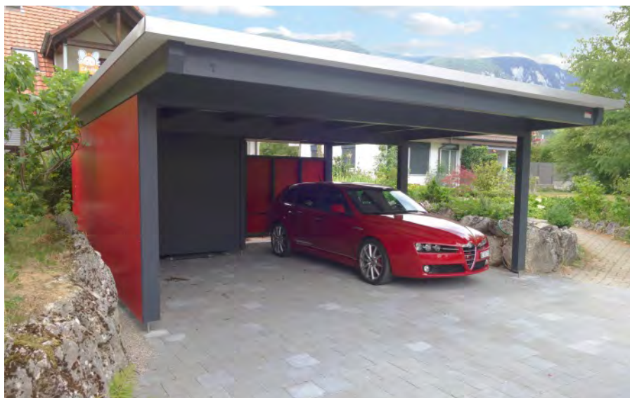
Carport mit Gründach, Verkleidung mit Vollkernplatten
