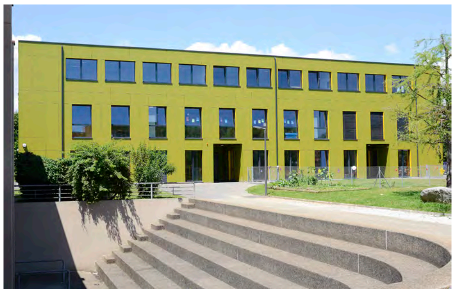
Markante Projekte der DM Bau AG (von oben): Prés-de-Vidy: Sozialer Wohnungsbau im Massivmodulbau in Lausanne. Urdorf: Asylunterkunft im Massivmodulbau. Kindertagesstätte Perretes, Gland VD: Rockpanel-Fassade mit raumhohen Fenstern.
